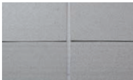
従来のシーリング工法
