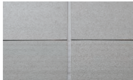
従来のシーリング工法 風雨・紫外線にさらされシーリングが劣化するため、メンテナンスが必要になります。
