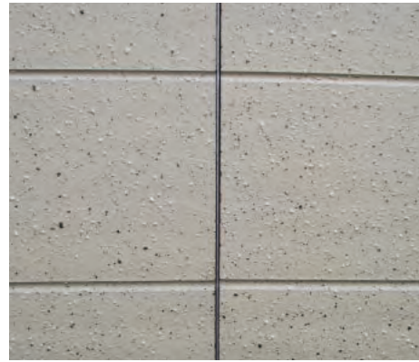
シールレス工法 劣化する部材の露出がないため、メンテナンスが削減できます。
