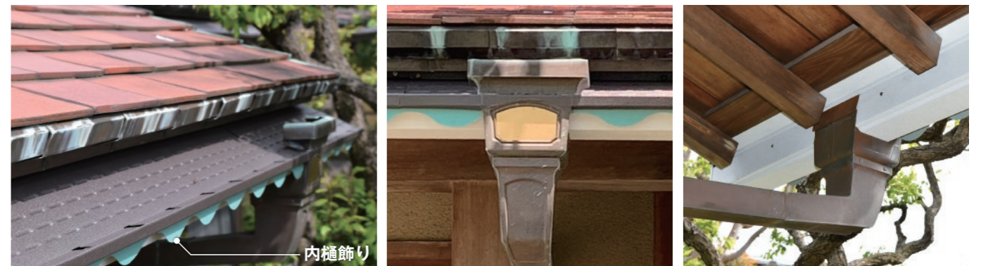
既存の銅縦樋を使用した元旦内樋リフォーム
