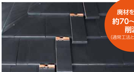
廻隅瓦を使用（調整瓦のカット後の廃材）
