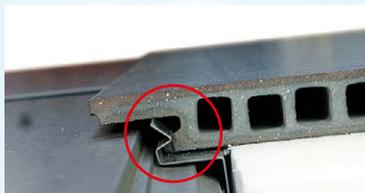
高強度と柔軟性を兼ね備えたステンレスのパネ鋼で、陶板を野地に固定。高い耐風性能を有する設計です。
