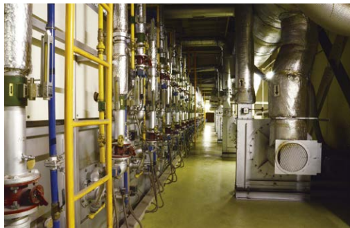
焼成用の窯側面バーナー部では 排熱の再利用率向上による省エネ化が進む
