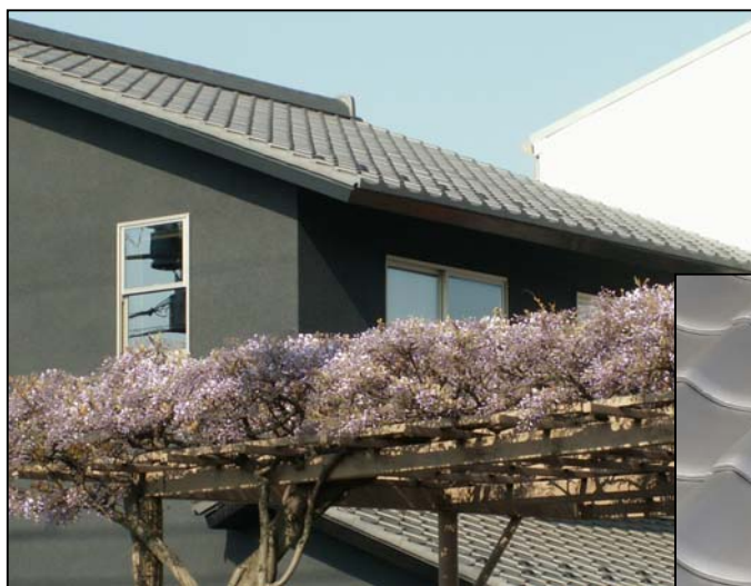
<施工物件写真>
