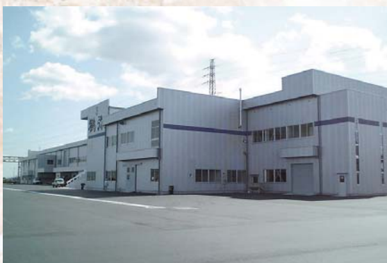
▲ 完成した阿久比工場第3ライン
