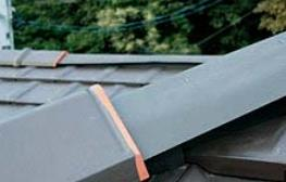
※防水性能試験において、時間降雨量240mm/hr、風速49m/s相当の圧力という厳しい条件で「漏水無し」という結果が得られました。(於愛知県三河産業試験場)
