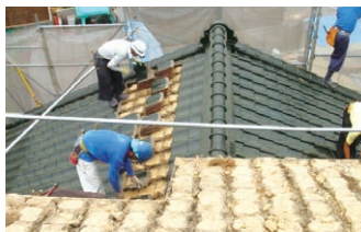
屋根のリフォーム工事
