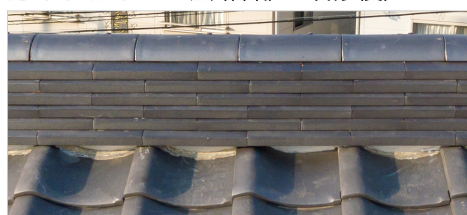
ガイドライン工法(棟部：改修後)
