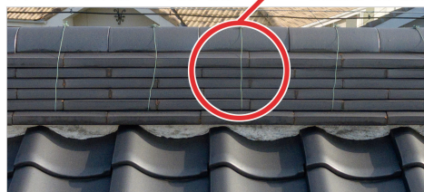
ガイドライン工法(棟部：改修後)
