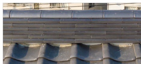
ガイドライン工法（棟部：改修後）
