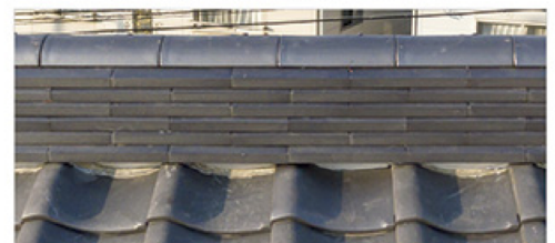
ガイドライン工法（棟部：改修後）
