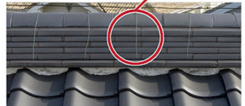
ガイドライン工法（棟部：改修後）
