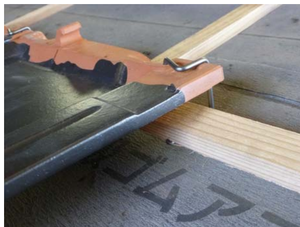
施工イメージ1
