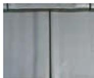
焼き物特有の若干のネジレ、寸法のバラツキにより施工後に瓦と瓦の間に若干の隙間が発生する事もあります。
