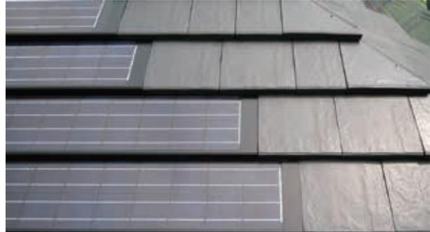
※写真はシャープ製 平板瓦一体型 太陽電池モジュールNE-38K1RとNE-53K1Rとの葺き合わせ
