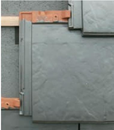
従来のスーパトライ110シリーズと同様に、スーパーロック工法でしっかり固定するので、台風時の強風や地震の揺れなどにも安心です。この工法により、特別な耐風工法(L釘・耐風クリップ等)を用いなくても十分な耐風・耐震性能を確保できる防災工法です。
